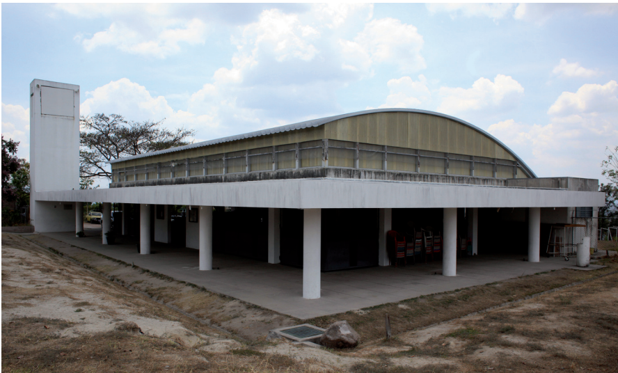
Vista exterior de corredor, iglesia Santa Alicia, Ilopango (García, 2008) Fotografía de Óscar Leiva (2012), propiedad de Fundación AccesArte
